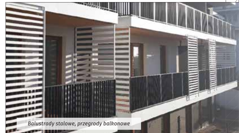
Balustrada stalowa – blacha wycinana laserowo
